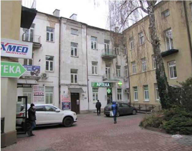
Widok budynku nr 2 od strony wewnętrznego dziedzińca.
