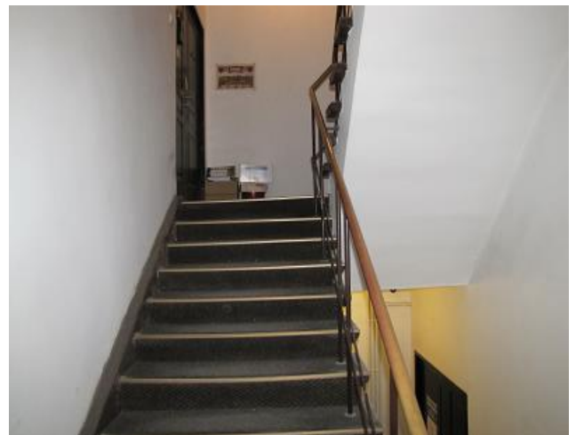
Wnętrze budynku mieszkalnego widok klatki schodowej na II piętrze.
