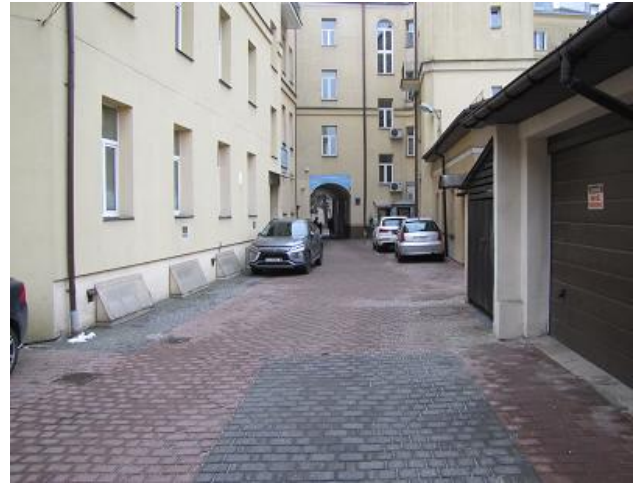
Widok budynku nr 1 od strony wewnętrznego dziedzińca.
